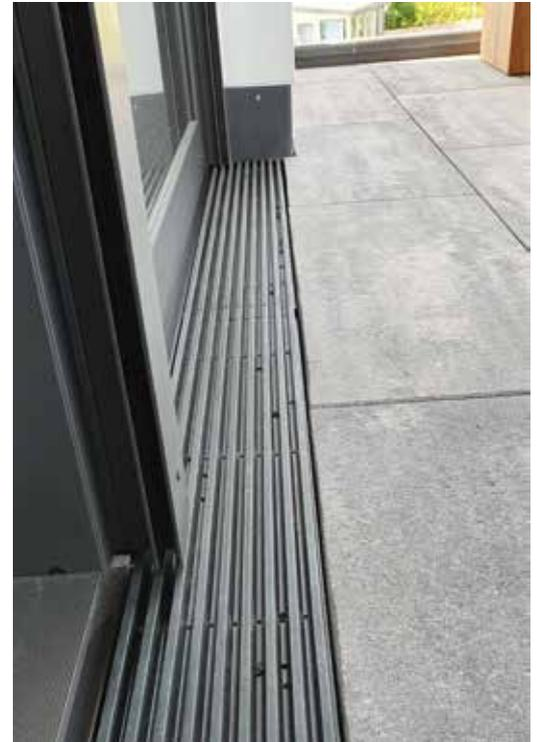
AquaStop Drain 150 (con fori di drenaggio)
