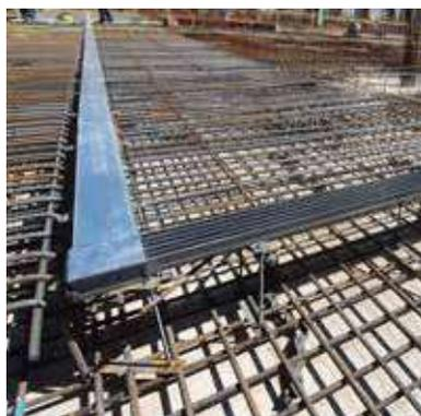
*Esempio di installazione con lamelle di fissaggio*
