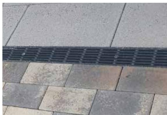
Canali di drenaggio VL100 con griglia a barre longitudinali in GFK col.antracite
