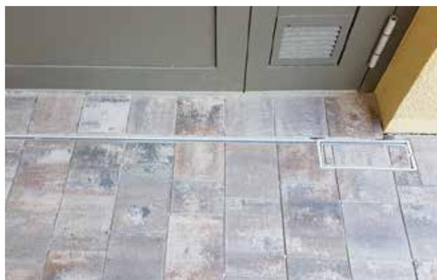
WOLFA – esempio di installazione con elemento di ispezione
