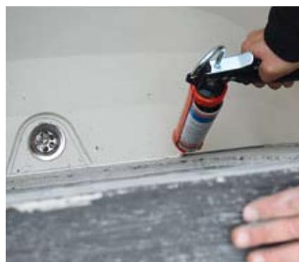
5. Sigillare bene con il silicone la parte interna della Bocca di Lupo. Lasciate indurire per un giorno e poi riempite a strati e ben compattati con la terra la parte esterna della Bocca di Lupo. La tenuta all'acqua può essere testata dopo 24 ore.
