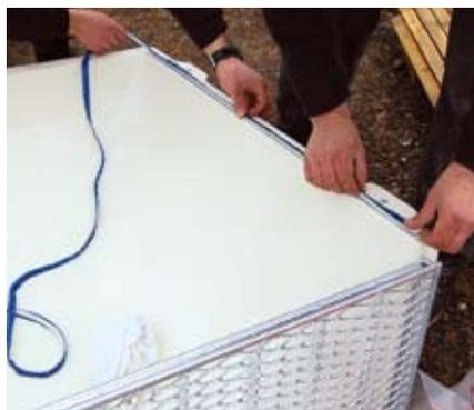
2. Usare del nastro adesivo sigillante nella scanalatura del bordo della Bocca di Lupo e del silicone nella parte inferiore, oltre al bocchello di scarico a tenuta.
