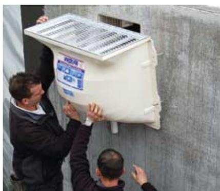
3. Installare la Bocca di Lupo con la griglia montata e stringere leggermente i tasselli al muro. Fare ulteriori fori per il montaggio. Iniettare nella fessura tra il muro e la Bocca di Lupo dell'altro silicone.
