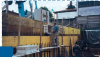
Posizionare, incastrandola nel registro, la finestra da installare, l'operazione di posa può essere effettuata da una sola persona.
