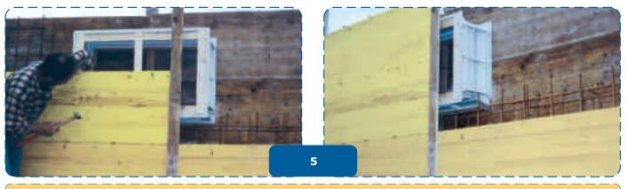
Completare l'armatura della cassaforma avendo cura di fissare il secondo registro anche nella parte interna.
